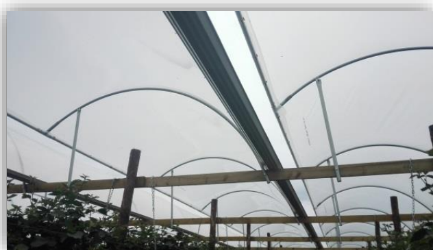
Figuur 30. – Opvang van hemelwater via goten tussen de regenkappen.
