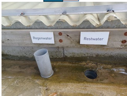
Figuur 43: Principevoorstelling afvoer via goot. Afvoer restvloeistoffen ligt altijd lager dan afvoer verontreinigd regenwater. Afhankelijk van de actie wordt de ene of de andere buis afgedicht
