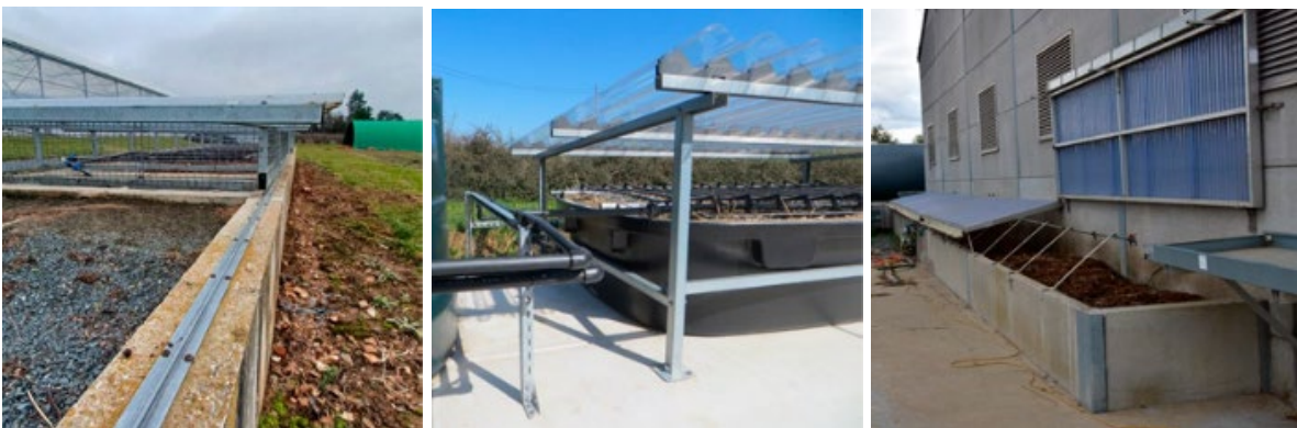
Figuur 39. Overzicht types dakconstructie: Links: Daksysteem op rail; Midden: Dak op vastgeschroefd metalen frame; Rechts: Scharnierend dak (bron: Protect'eau)
