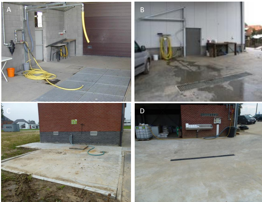
Figuur 2: Enkel voorbeelden van vul- en spoelplaatsen in de praktijk met (A en B) overdekte vul- en spoelplaatsen voor boomgaardspuiten en (C en D) niet-overdekte vul- en spoelplaatsen voor volleveldspuiten
