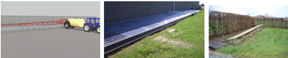
Figuur 5: Voorbeelden van eenvoudige dakconstructies met opvang voor restwater van de interne reiniging van het spuittoestel.
