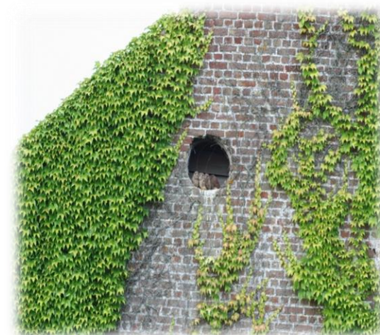
Figuur 14. – Dichtgetimmerd uilengat met jonge torenvalken.
