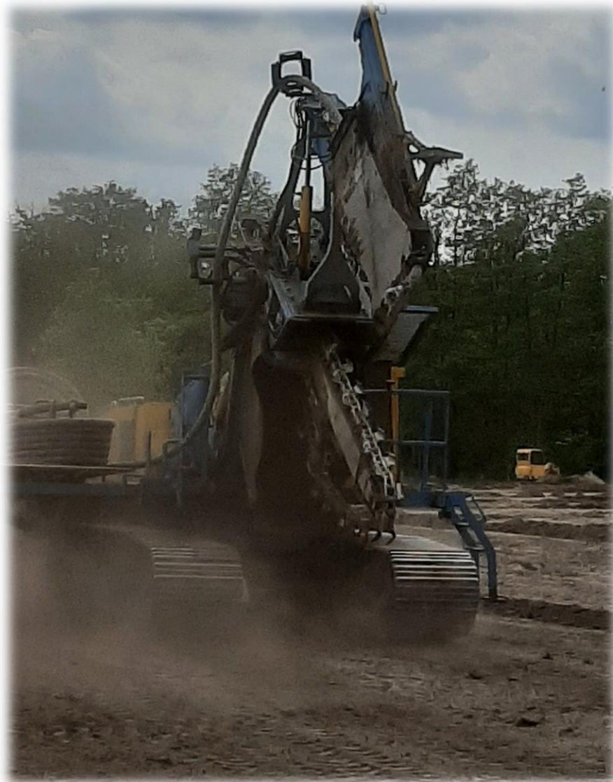
Figuur 46__ Kettinggraver waarmee drainage aangelegd wordt op zandige percelen(Barth drainange B.V.).
