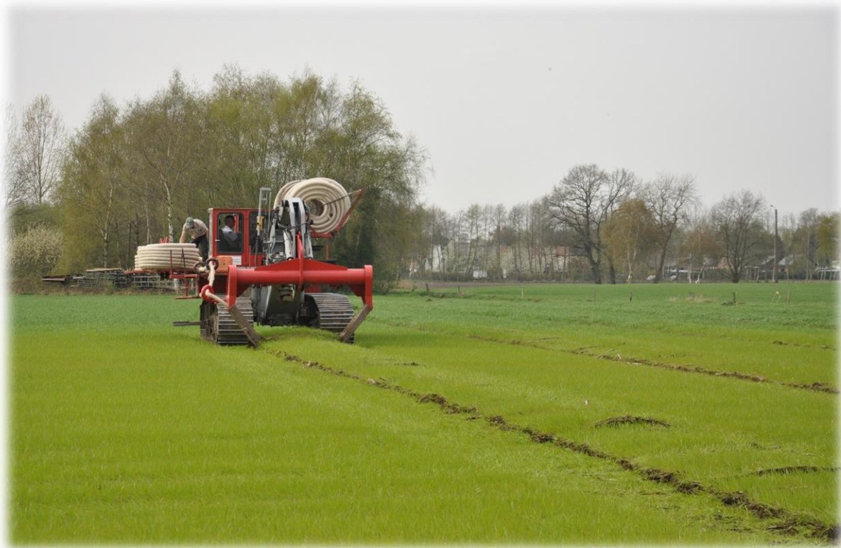
Figuur 42. – Aanleg van peilgestuurde drainage. Opmerking: aanleg van een peilgestuurde drainage is niet subsidieerbaar via VLIF-NPI; enkel de omvorming van een gedraineerd perceel naar een peilgestuurde versie, is subsidiabel!
