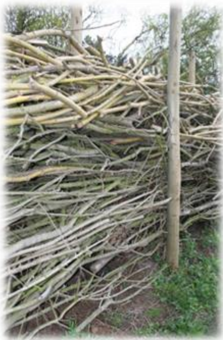
Figuur 47. – Wilgentenendam als erosie maatregel
