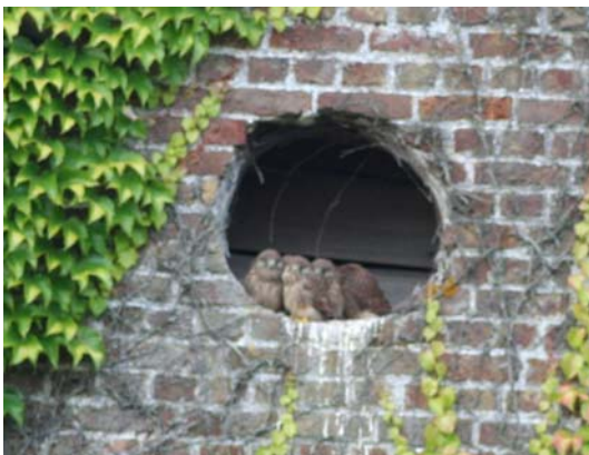
Dichtgetimmerd uilengat met jonge torenvalken
